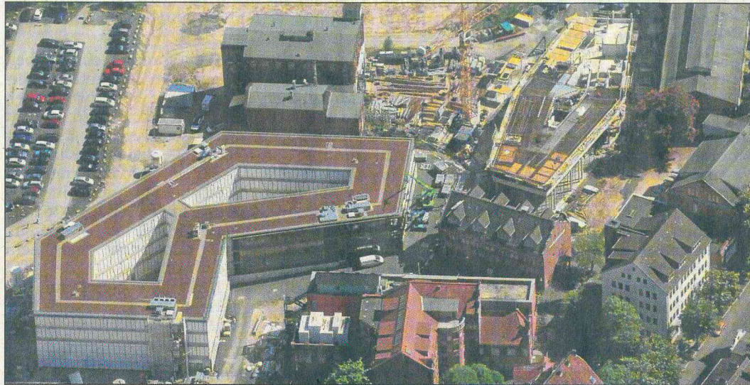
Brezelbau für kluge Köpfe: Der Science Park Kassel (brezelförmiges Gebäude unten links) auf dem Unigelände zwischen Mombach- und Gottschalkstraße nimmt Gestalt an. Rechts oben im Bild der Neubau für das ASL-Gebäude der Uni.
