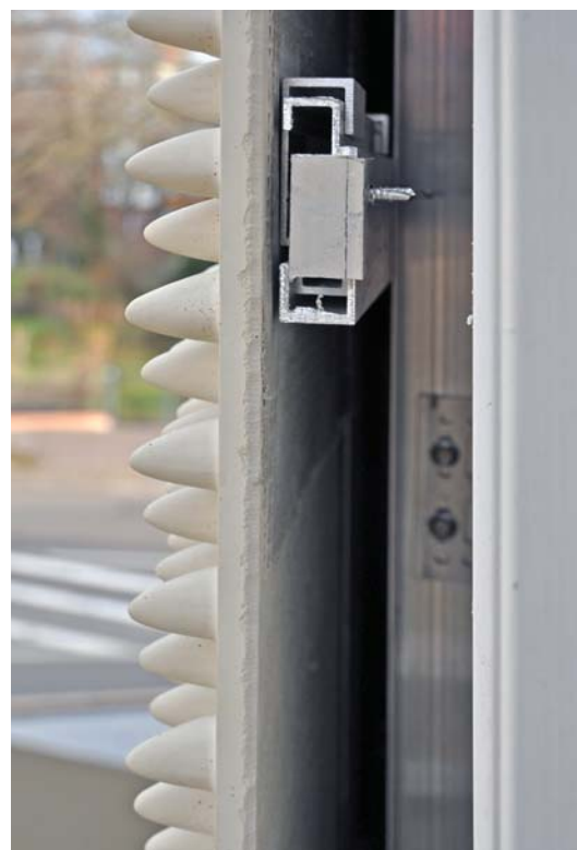
Detail VHF Unterkonstruktion und Agraffen aus Aluminium
