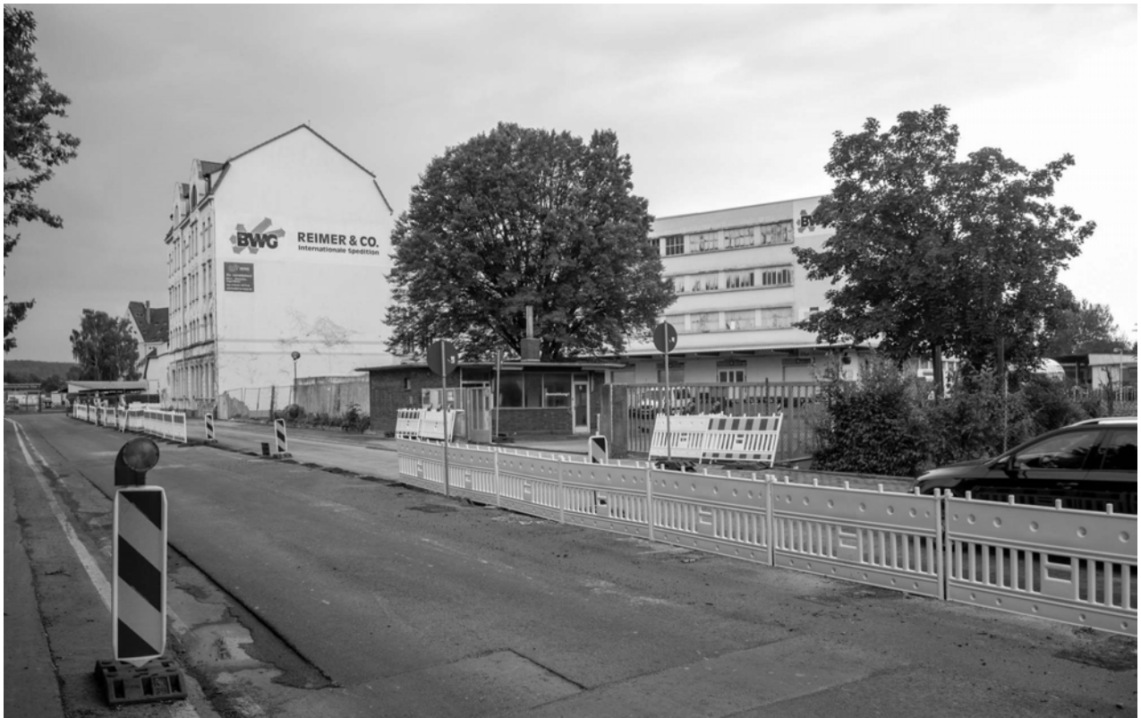
Das Denkmal Hafenstraße 76 bildet den Auftakt der Hafenzone
