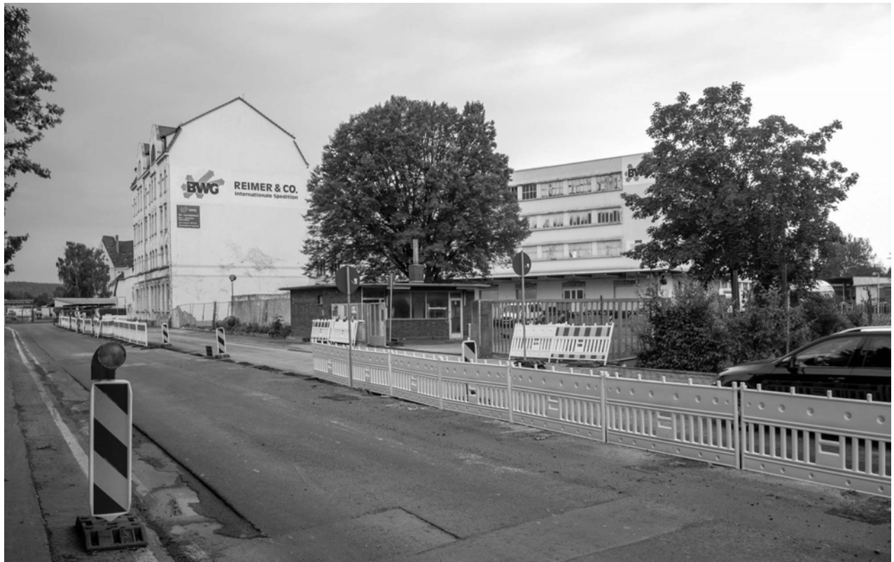
Das Denkmal Hafestraße 76 bildet den Auftakt der Hafenzone
