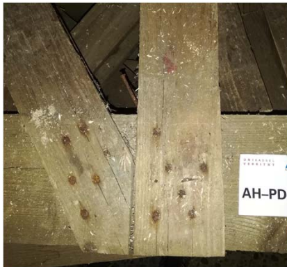
Abb. 1: Knoten des Pultdachträgers
