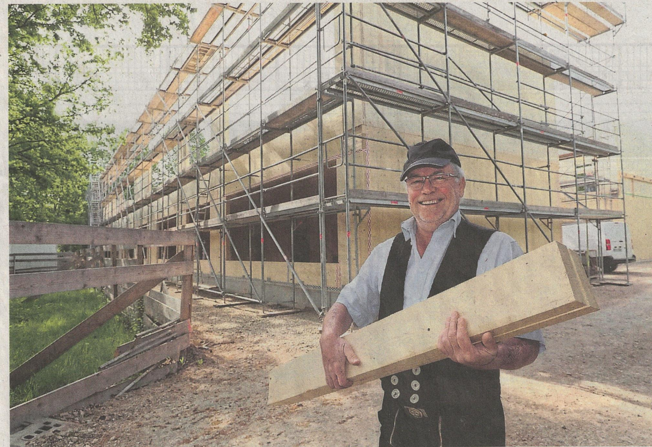
Erstellt mit seinem Team den Holzrohbau für die Ernst-Leinius-Schule innerhalb weniger Tage: Zimmerermeister Jürgen Langhuth von der gleichnamigen Lohfeldener Holzbau-Firma auf der Harleshäuser Baustelle. FOTOS: ANDREAS FISCHER
